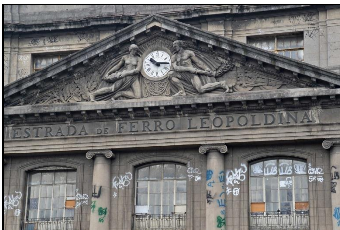
Acima: Parte frontal da estação
